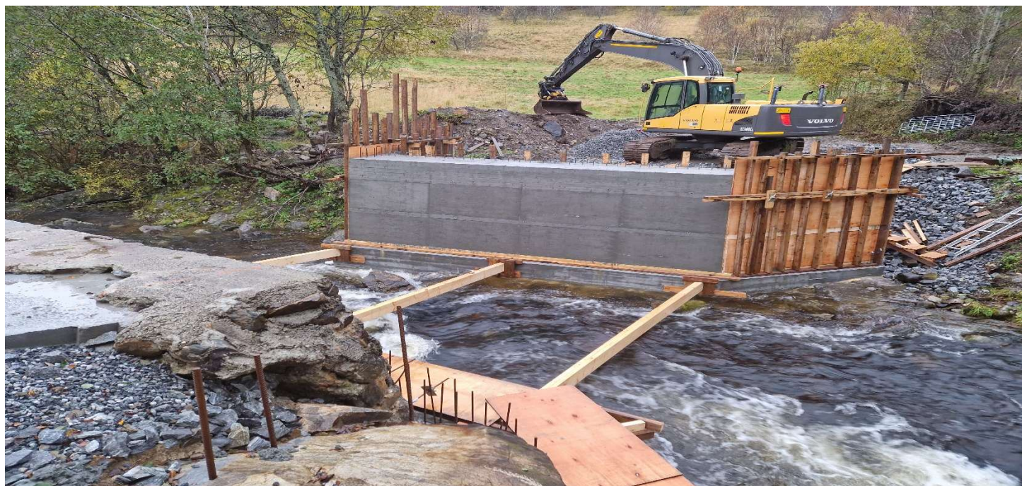
Startet ombygging skogsbilvei kl. 3 Lessengmoen og bygge ny bru i Røymarka
