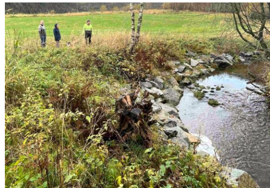
Arbeidsgruppa for SMIL-midler får se steinsetting av elv i Kjørsvik for å forebygge erosjon. Foto: Nils Nyborg
