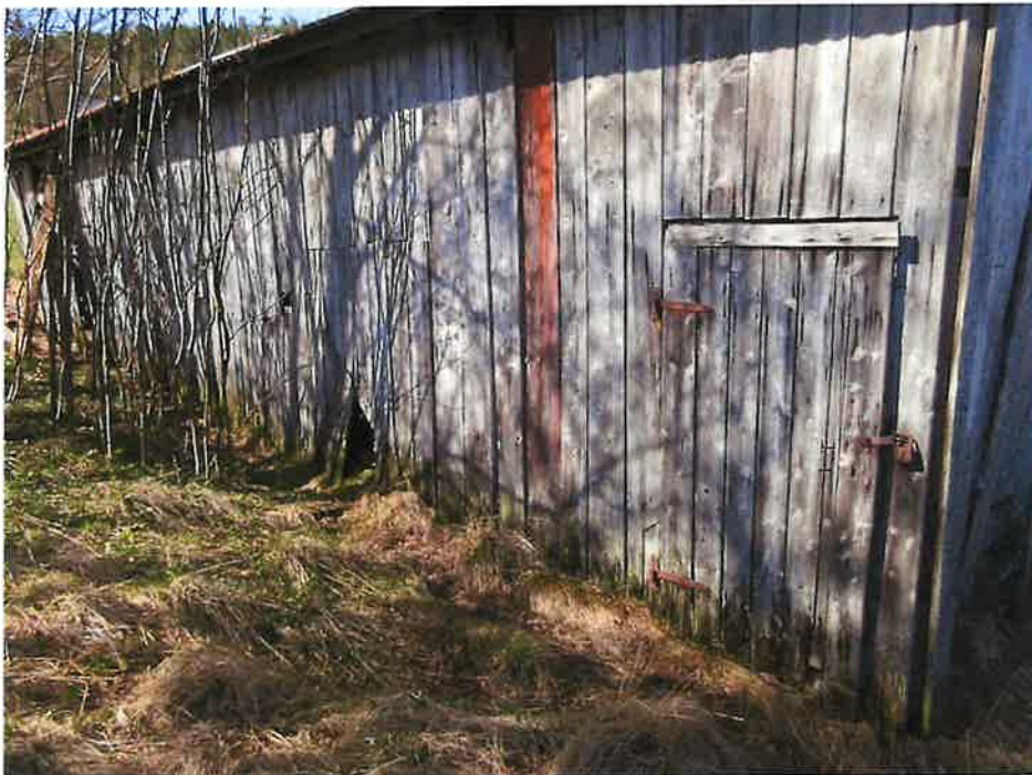
Nordvegg med dør
