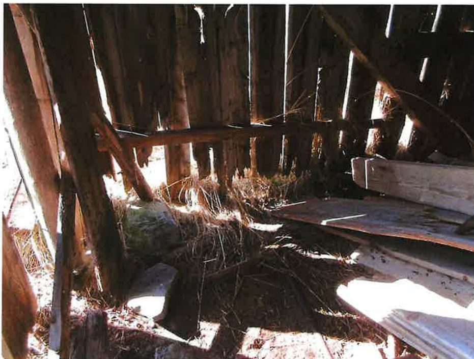
Syllstokker fullstendig vekkråtnet
