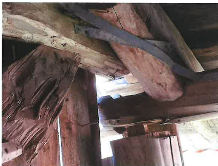
Raftstokk glidd fra og forsøkt reparert
