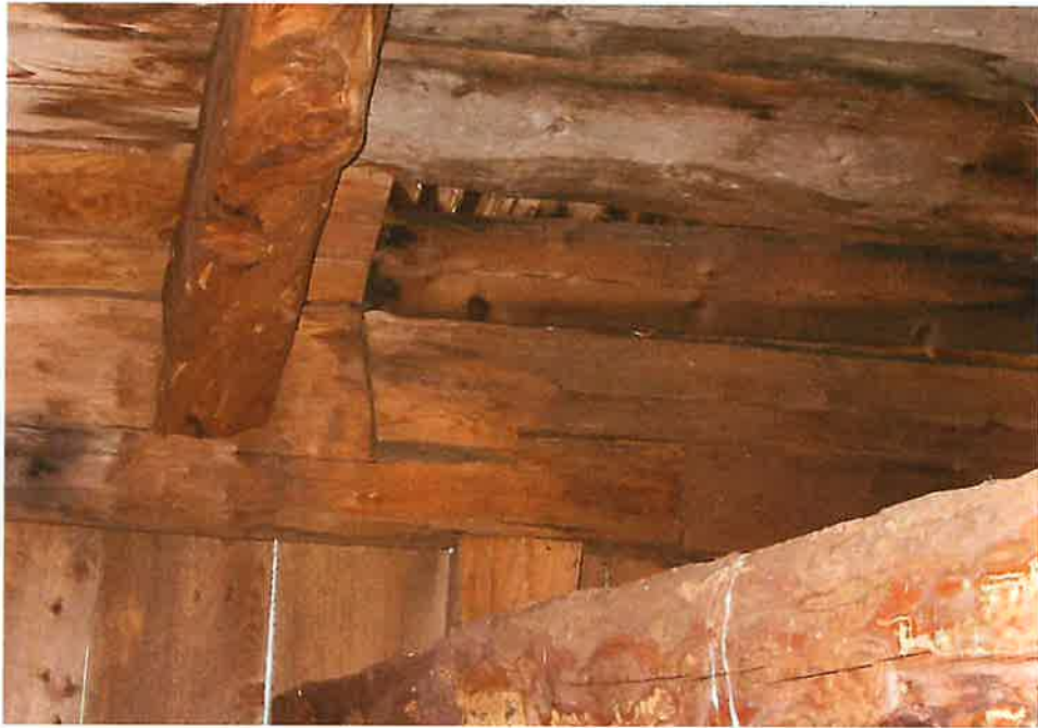
Skjøt i raftstokk
